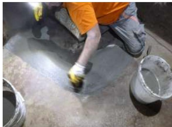
Sanierung im Hochbehälter mit Spezialmörtel
