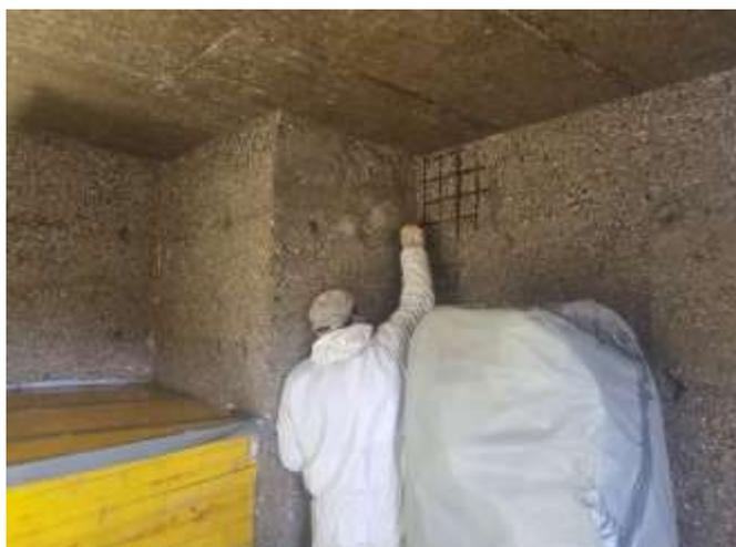
Deswegen werden beide Behälter durch eine Spezialfirma mittels einer speziellen Spritzbetonbeschichtung saniert und die Rohrleitungen in Edelstahl neu ausgeführt. Somit kann für die nächsten Jahrzehnte
